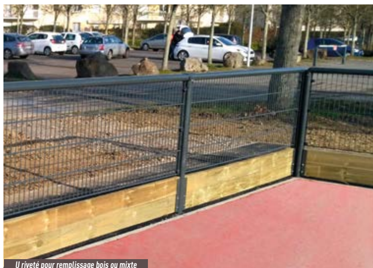
U riveté pour remplissage bois ou mixte
