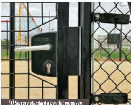
(1) Serrure standard à barillet européen
