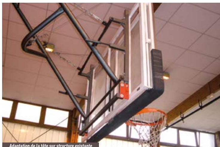
Adaptation de la tête sur structure existante
