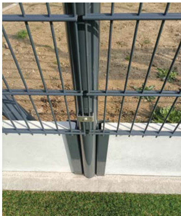
U riveté pour remplissage bois ou mixte
