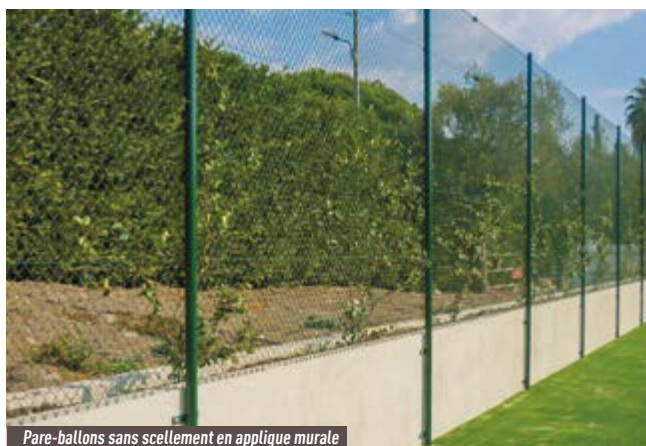
Pare-ballons sans scellement en applique murale
