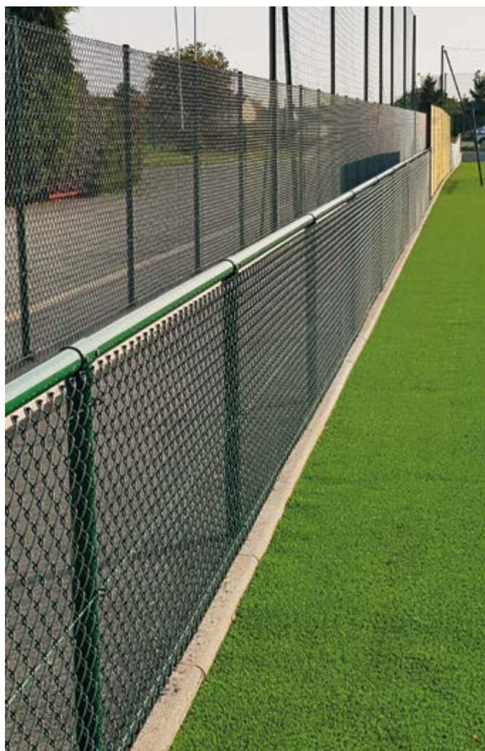
Remplissage simple torsion et adaptation au changement d'inclinaison du terrain
