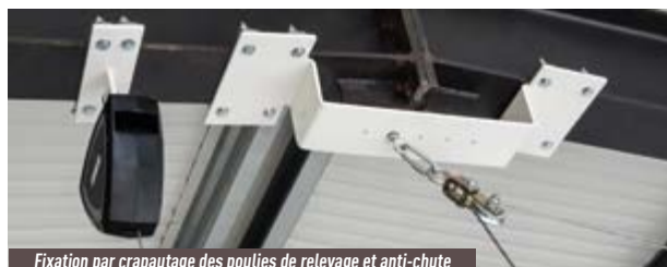
Fixation par crapautage des poulies de relevage et anti-chute
