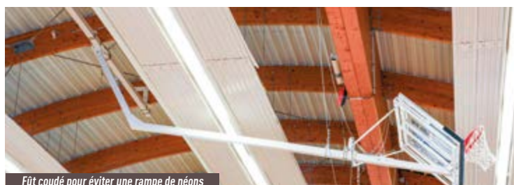
Fût coudé pour éviter une rampe de néons
