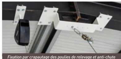
Fixation par crapautage des poulies de relevage et anti-chute
