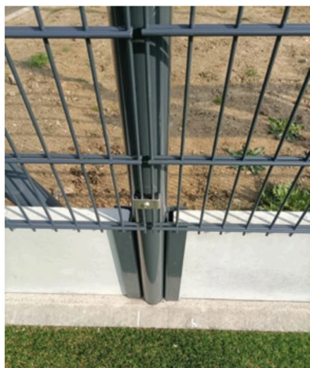
U riveté pour remplissage bois ou mixte
