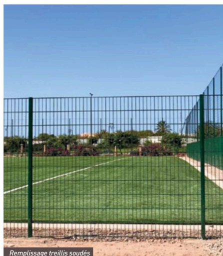
Remplissage treillis soudés
