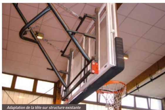
Adaptation de la tête sur structure existante
