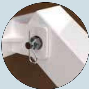
Au niveau de la platine de fixation du fût à la charpente, une goupille sécurise l'écrou pour éviter que les vibrations ne provoquent un desserrage.
